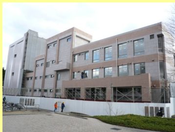
▲北西側（大学会館前）より
